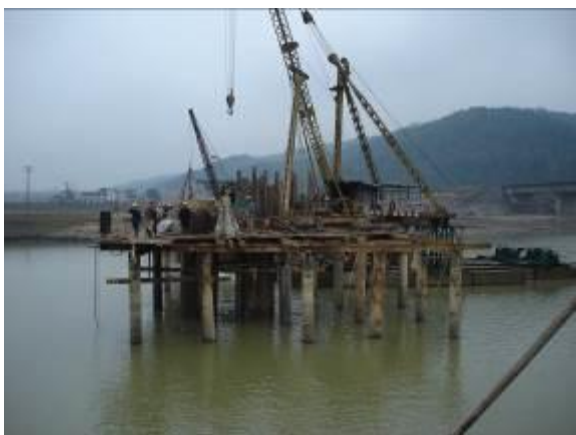
典型跨河桥梁钢板桩围堰施工现场
