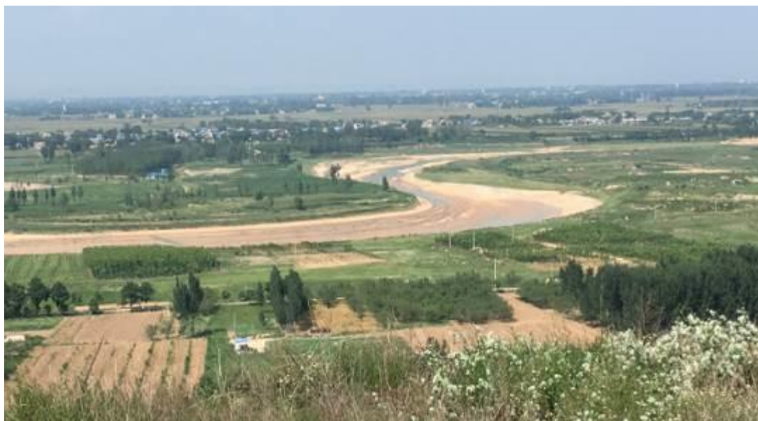
泾河桥址位置
