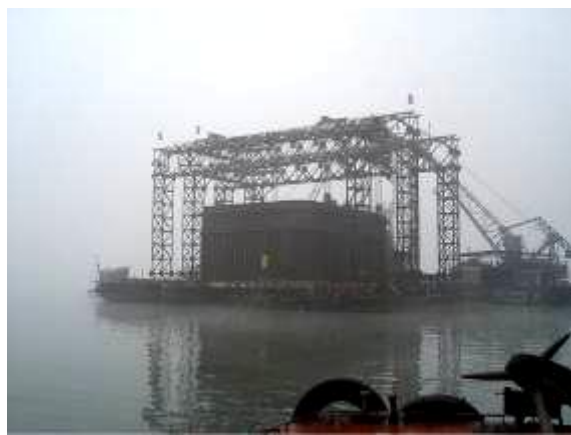
典型跨河桥梁钢壁围堰施工现场
